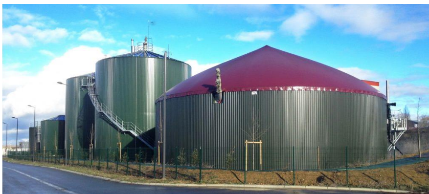
Figure 46 : l'unité de méthanisation Biogaz à Auch
