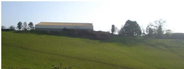
Elevage bovin, entrée Nord du village
