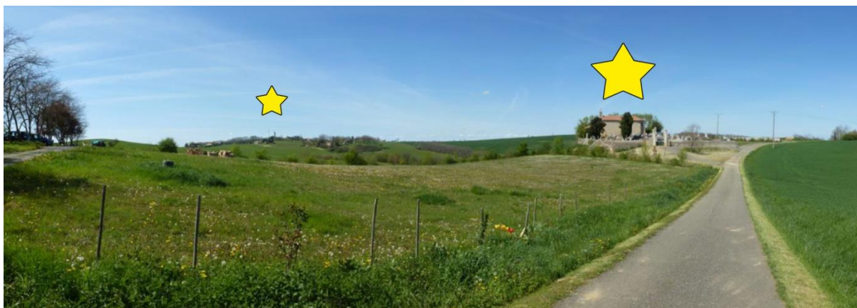
Le château d'eau et la chapelle
